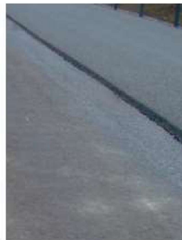
Rätt! Rak längsgående fog med hjälp av kantpackare. Fogen är fri från lösa stenar.
